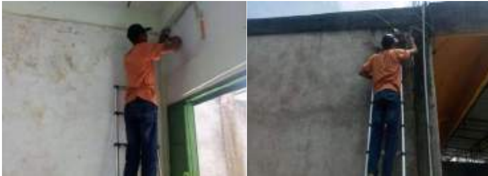
Gambar 3.5 Perbaikan Jaringan CCTV
