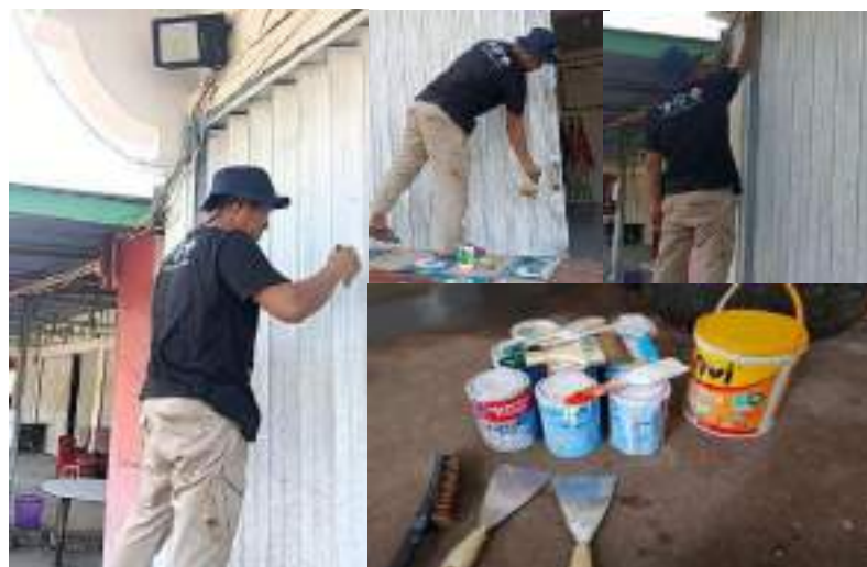
Gambar 3.3 Kegiatan Pengecatan Fasilitas Perkantoran
