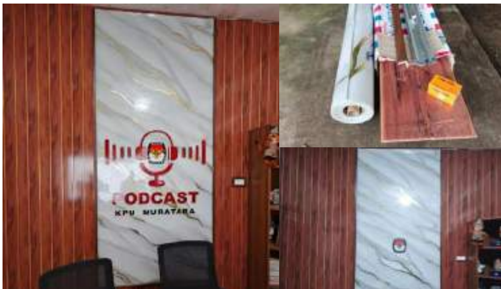
Gambar 3.6 Pemasangan Backdrop Ruang Podcast
