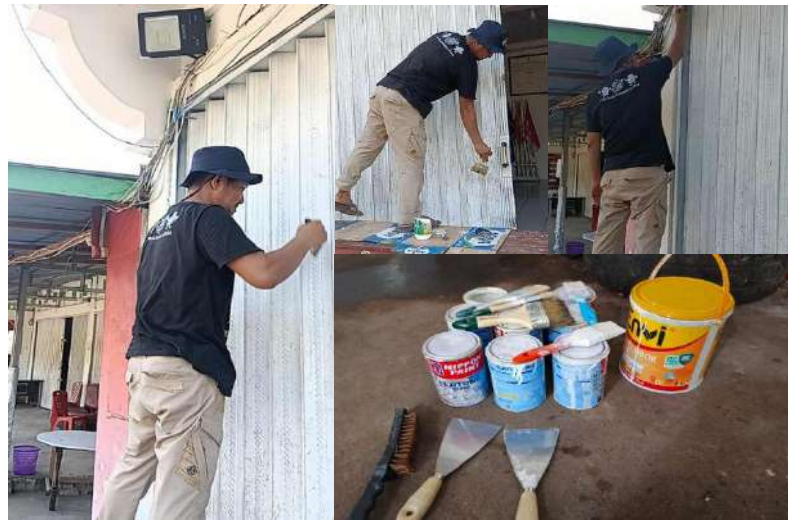
Gambar 3.3 Kegiatan Pengecatan Fasilitas Perkantoran
