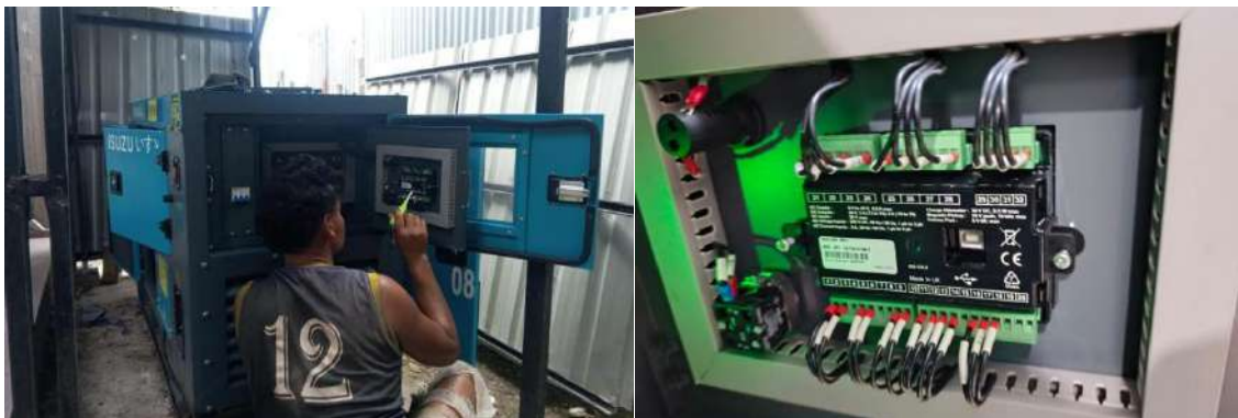
Gambar 3.4 Perbaikan/Servis Genset
