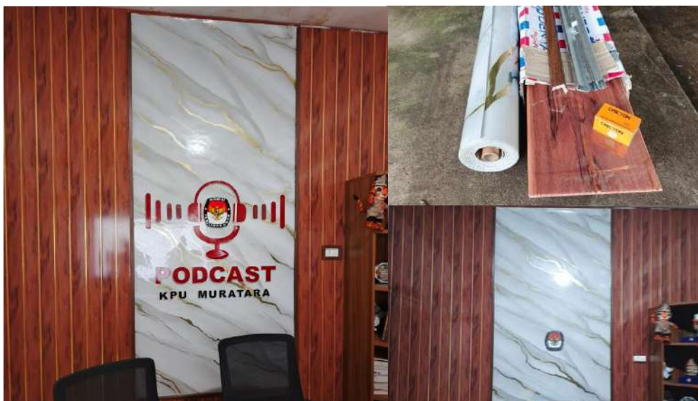
Gambar 3.6 Pemasangan Backdrop Ruang Podcast
