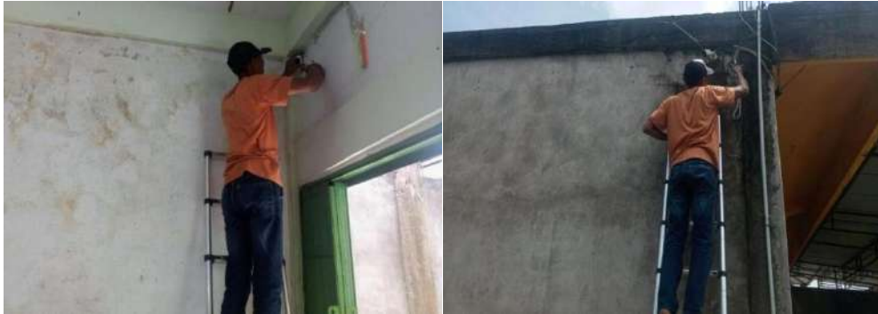
Gambar 3.5 Perbaikan Jaringan CCTV
